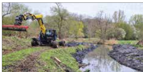
Bei der Entschlammung des Mühlengrabens kam ein Schreitbagger zum Einsatz.
