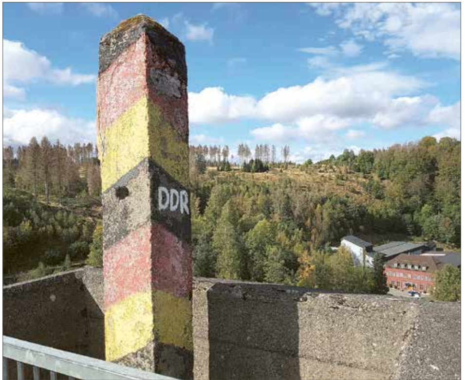
Die ehemalige innerdeutsche Grenze auf der Staumauer ist bis heute mit dem alten Grenzstein gekennzeichnet. Rechts unten ist die Anlage des Wasserwerks zu sehen.
