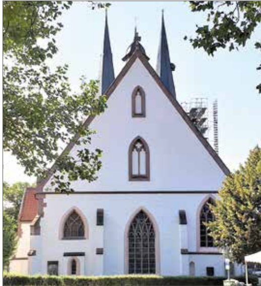
Die St.-Nicolai-Kirche in Alfeld.
