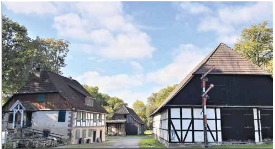
Die ehemalige „Treppmühle“, drei Zehntscheunen und eine ausgediente Feldbahn.
