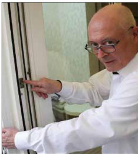
Clemens Rumpf zeigt die schwachen Beschläge dieser Terrassentür, die schnell aufgestemmt werden können. Er rät zu einer Nachrüstung mit einbruchshemmenden Beschlägen.
