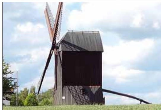
Am Aseler Ortsrand steht die Paltrockmühle, die vom Mühlenverein vor dem Verfall bewahrt wurde.
