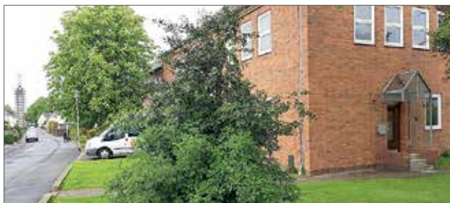
Zur Bürgermeister-Sprechstunde geht es durch die Tür rechts.
