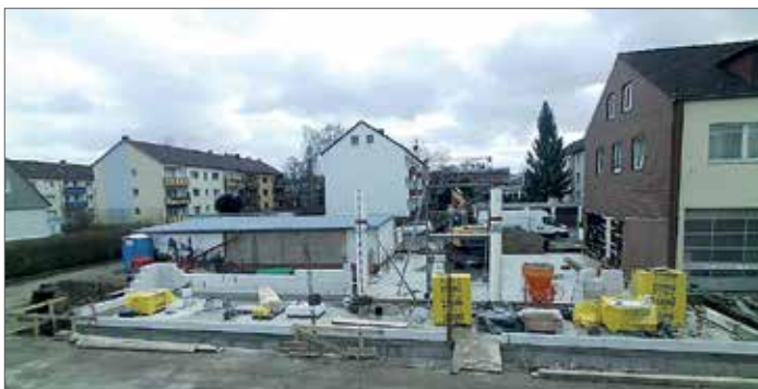
Im Januar 2018 begannen die Maurerarbeiten für die Fahrzeughalle.
